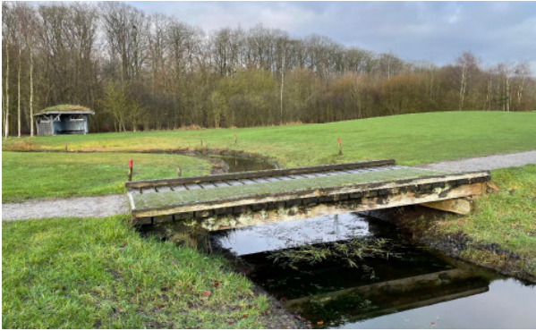
1e brug van hole 6
