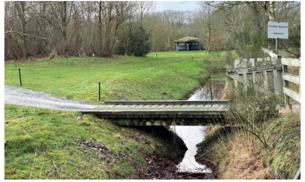
Brug - ingang van hole 3 - Dam/duikers
